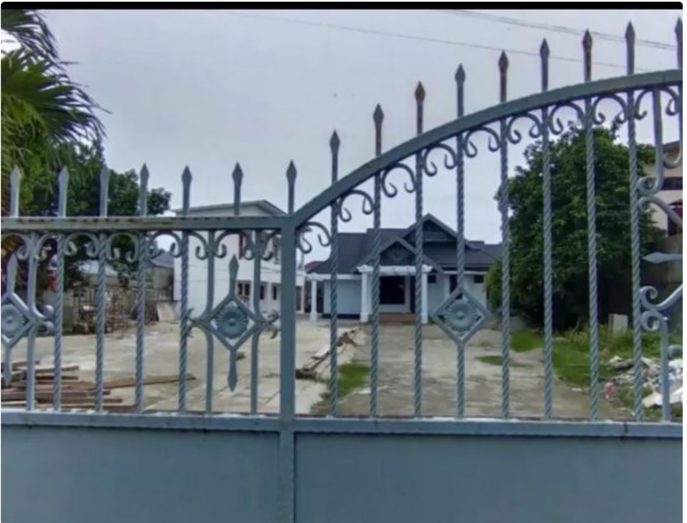
Mess Pemda Morowali di jln Garuda Palu
