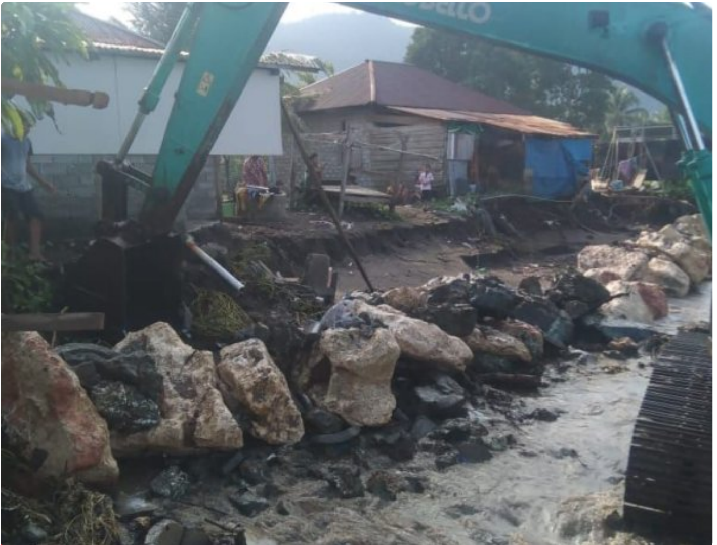
Proyek pemecah ombak di desa kolono
