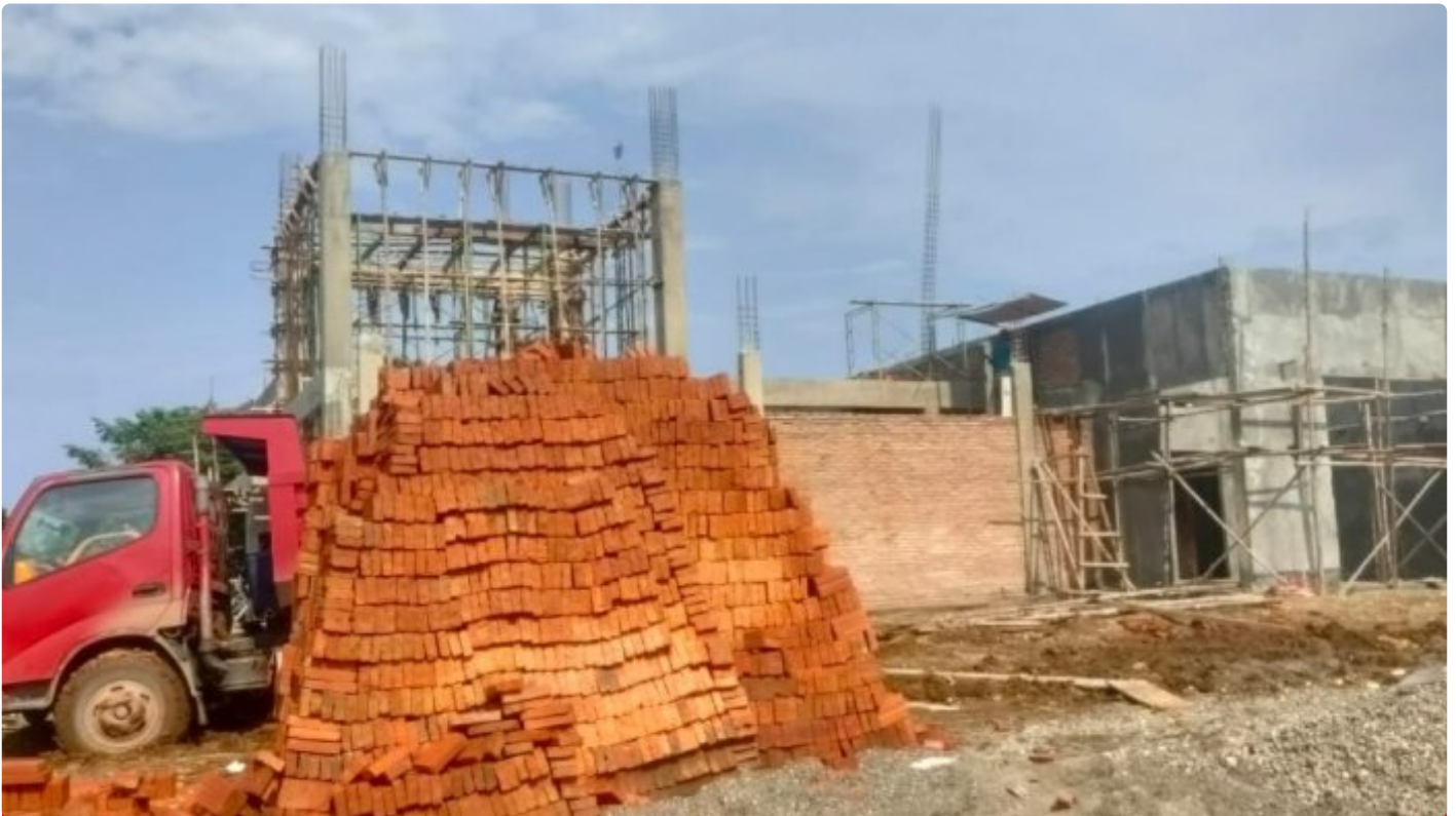
Tampak Pembangunan Kantor Inspektorat Morowali sedang berlangsung
